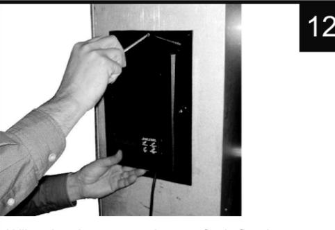
Utilisez les vis auto taraudeuses afin de fixer le purificateur au conduit de ventilation. Il ne vous reste plus qu'à brancher l'appareil et d'activer l'interrupteur rouge (en dessous) et le tour est joué!
